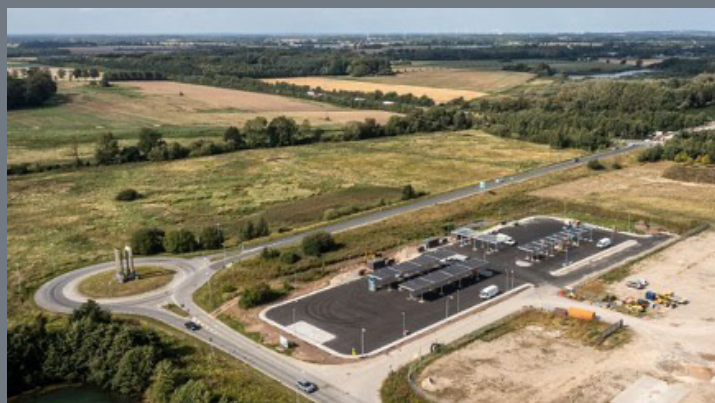
30 lynladepladser med 300 kW og solceller på taget er åbnet i Langeskov på Fyn. Foto: Vejdirektoratet
